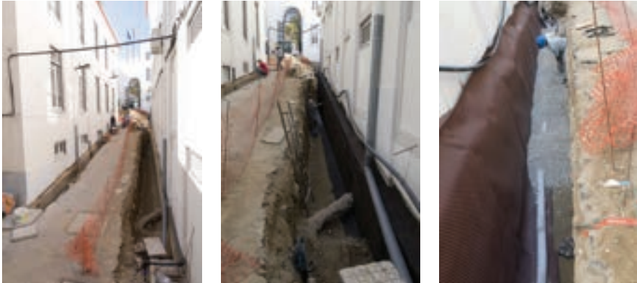
Figuras 6, 7 e 8: Três fases que retratam os trabalhos de isolamento da parede exterior dos depósitos, sendo que, na base do fosso, foi instalado um dreno para encaminhamento das águas pluviais, de modo a permitir que o terreno, junto das paredes dos depósitos, fique seco mais rapidamente do que o solo circundante.
