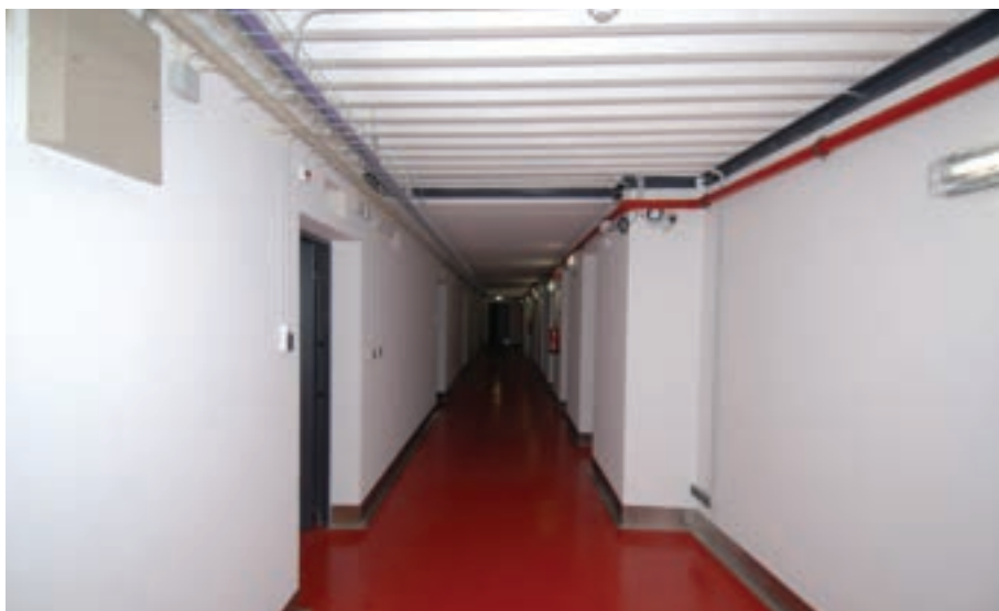
Figura 12: Corredor dos depósitos podendo destacar:
