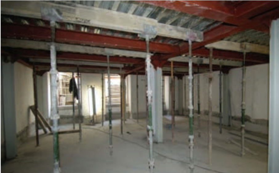
Figura 15: Instalação do piso intermédio.
