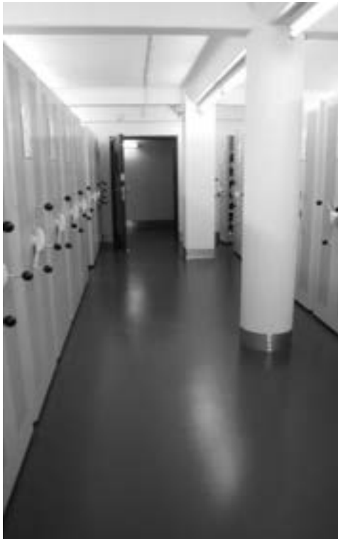
Imagem 5: Depósito de documentação equipado com estantes rolantes compactas.
