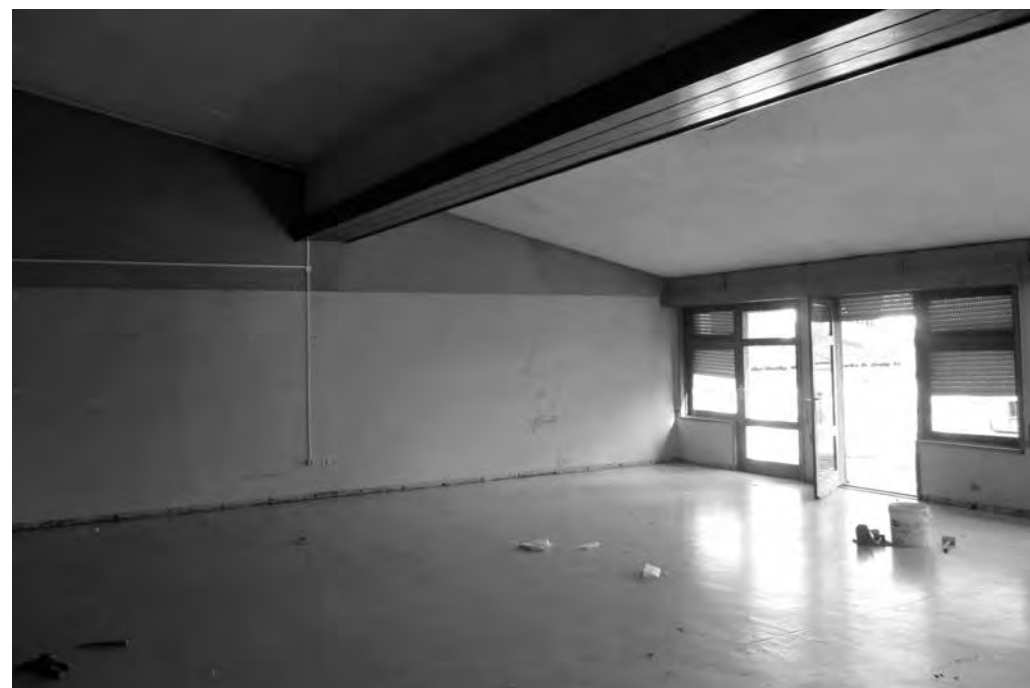
Reabilitação da Creche e Jardim de Infância da SCM de Riba d'Ave.
