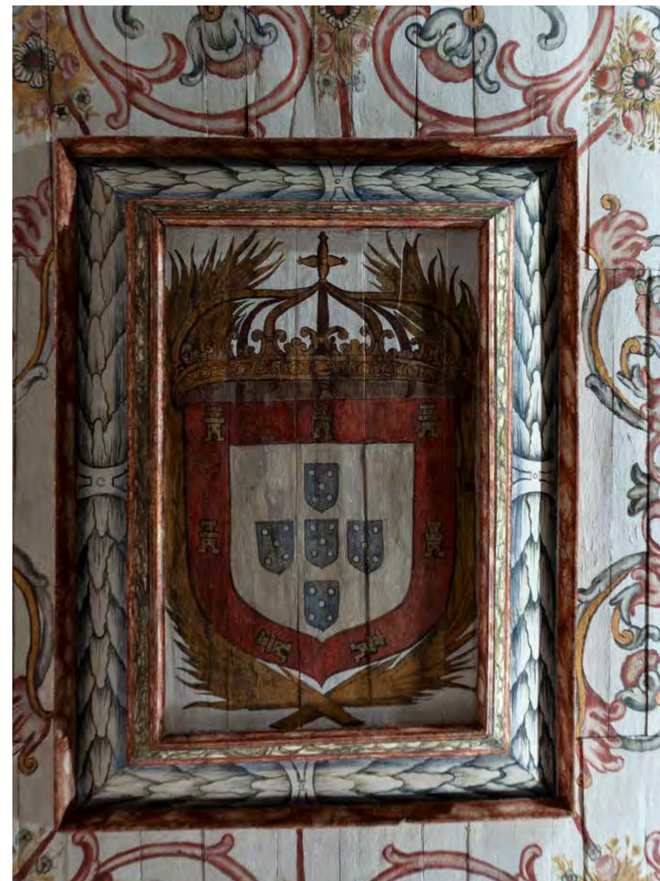
As Armas de Portugal no tecto da Sacristia. Degradadas e recuperadas.
