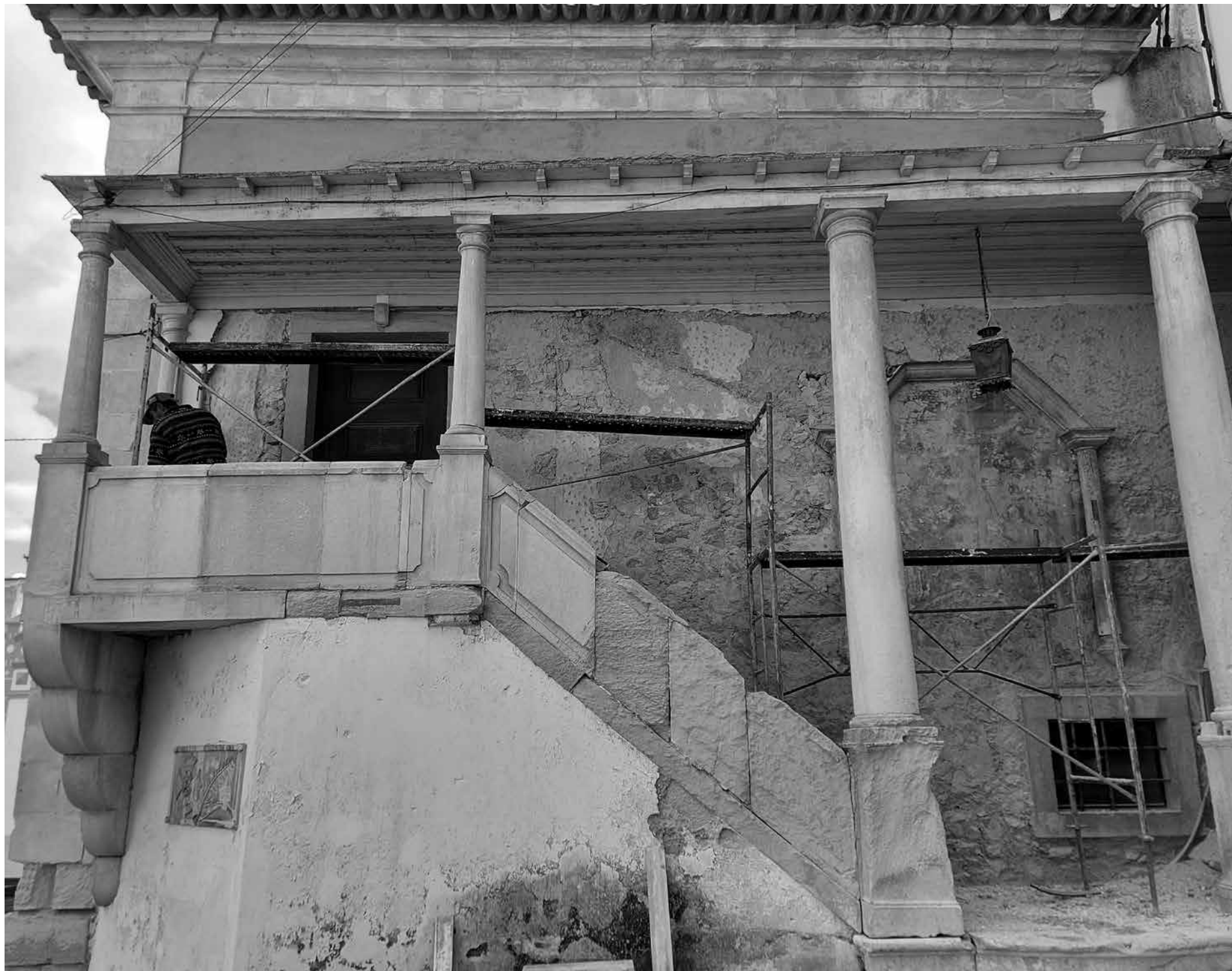
Obra na fachada lateral onde foi possível recuperar a maior parte a pintura mural do Senhor dos Aflitos, de grande devoção local. Imagem oportuna para preces junto ao antigo Hospital.
