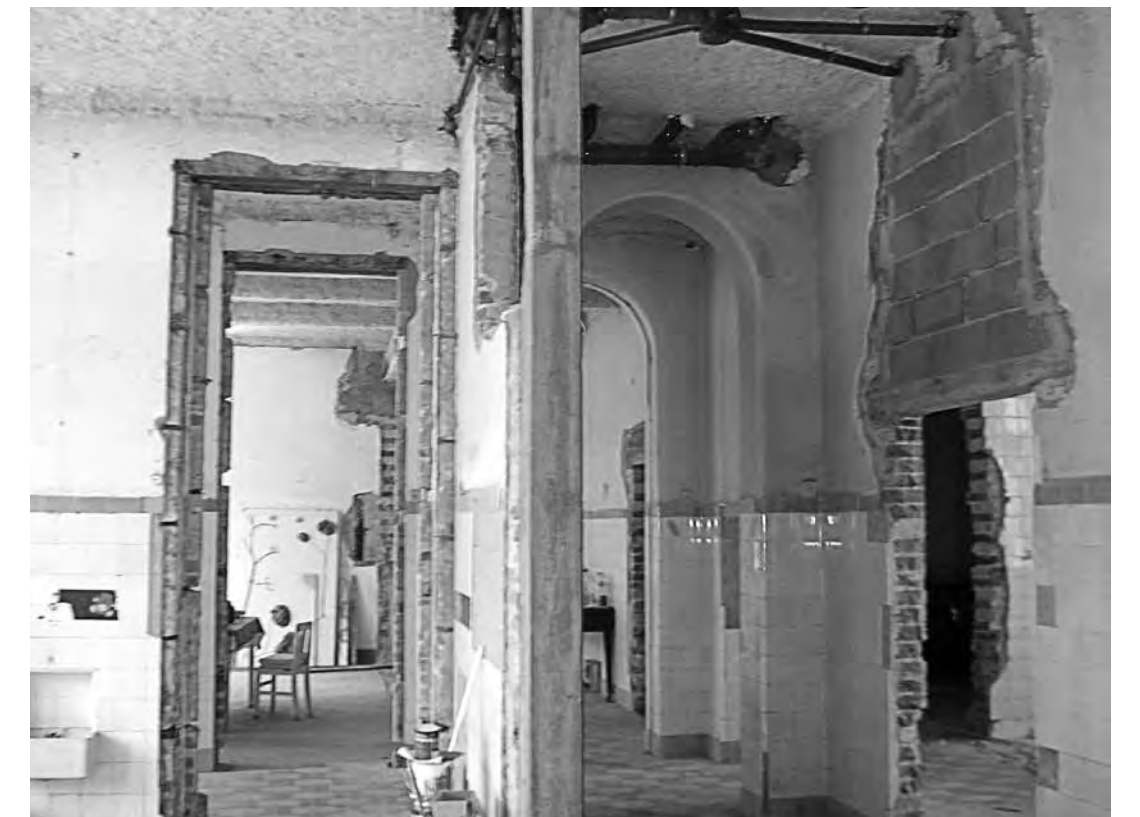
Remodelação do antigo Hospital da SCM de Almeirim para Creche e Jardim de Infância.
