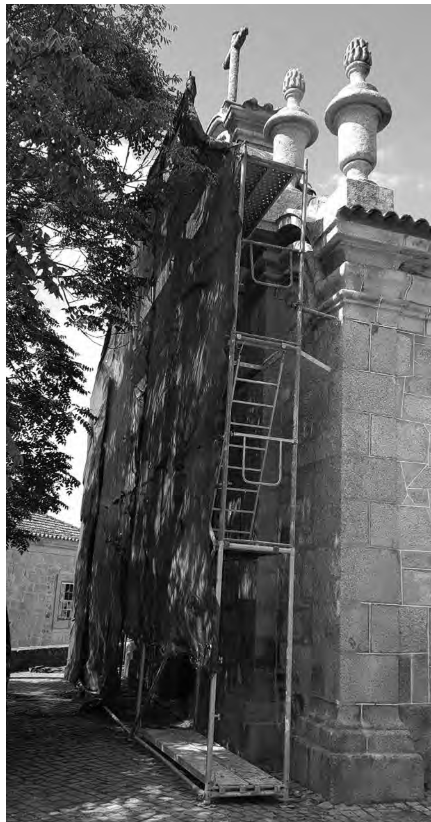
Fachada principal em obra.
