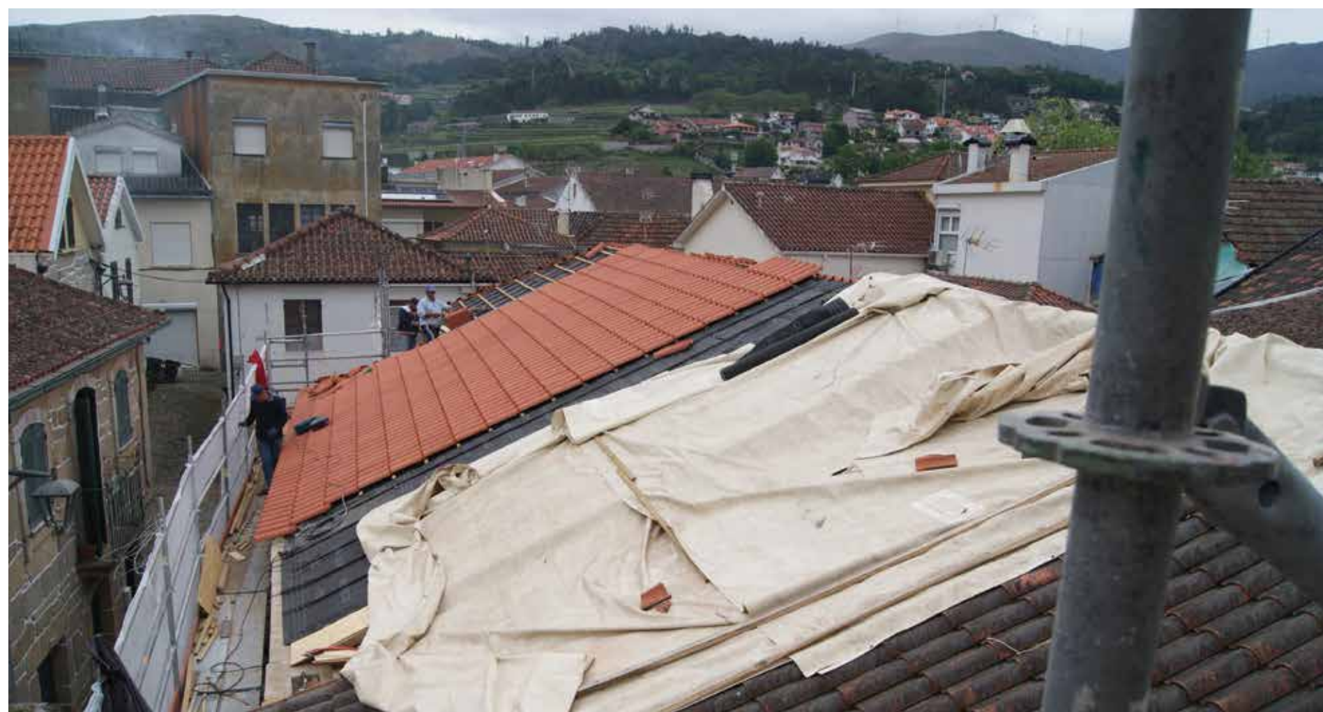
Aspectos da obra na cobertura e paredes exteriores da Igreja do século XII que passou para a Misericórdia no século XVI.
