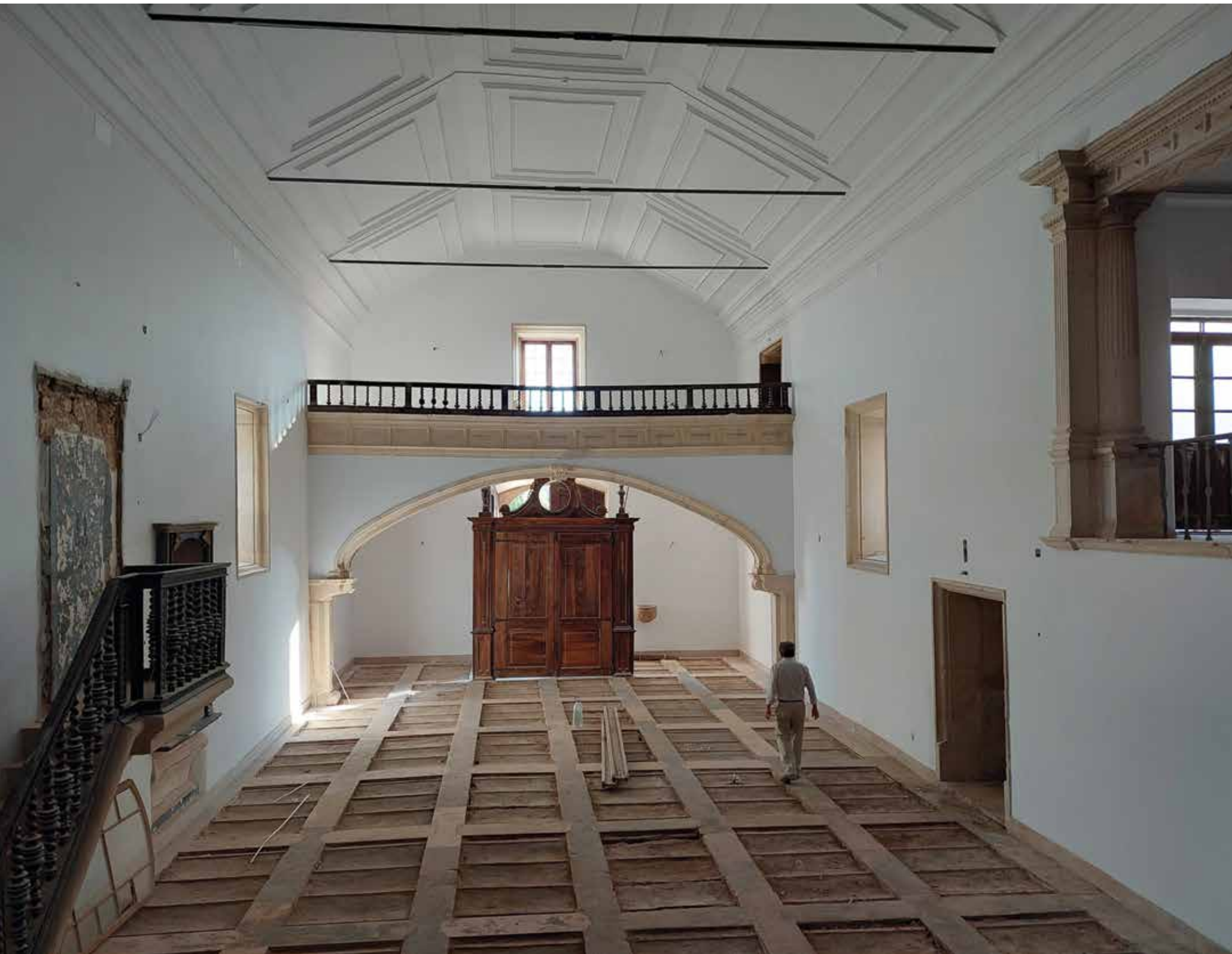
O pavimento da igreja estava apodrecido e foi substituído por madeira de carvalho.
