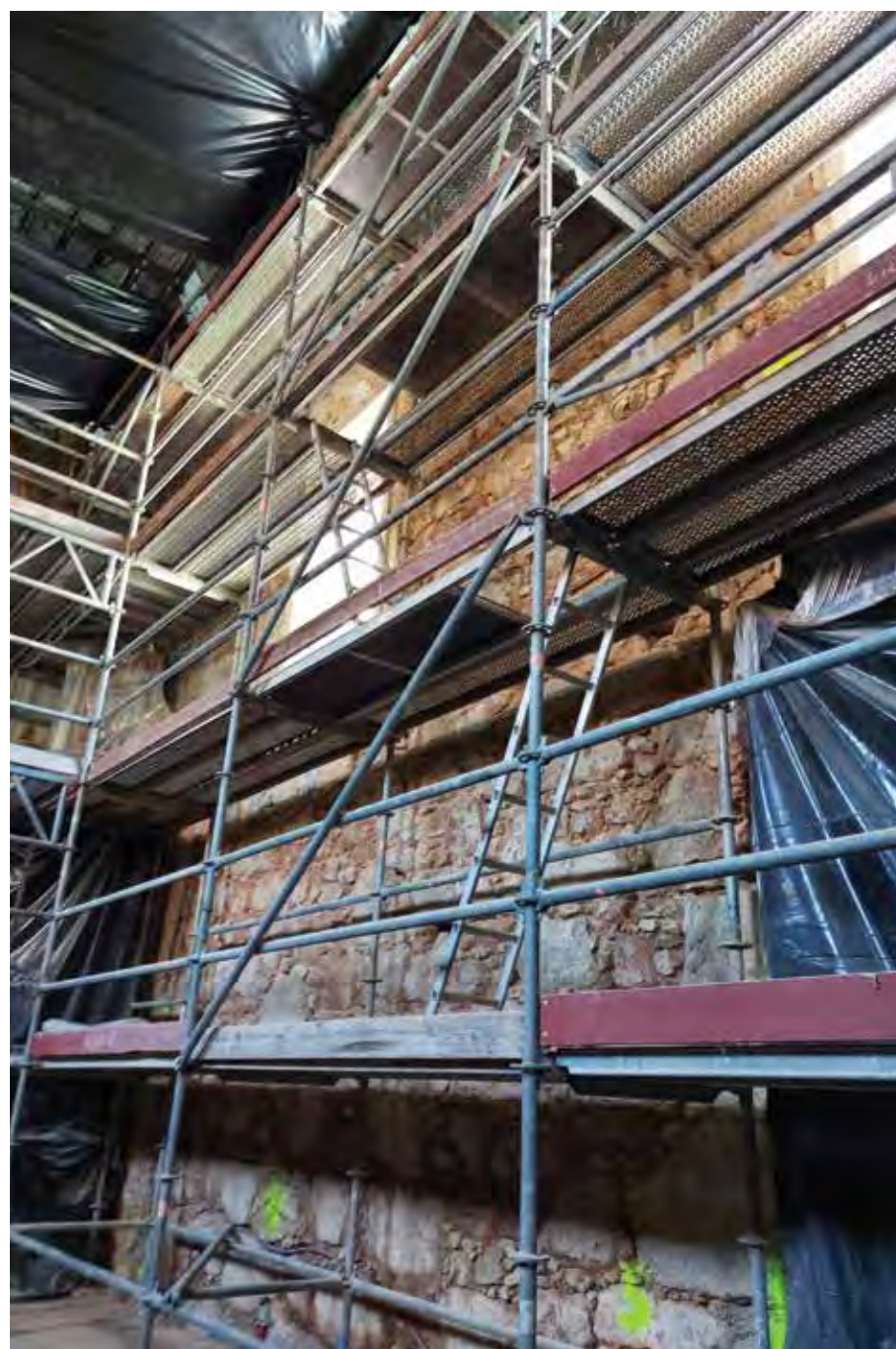
Aspecto da obra no interior da igreja.
