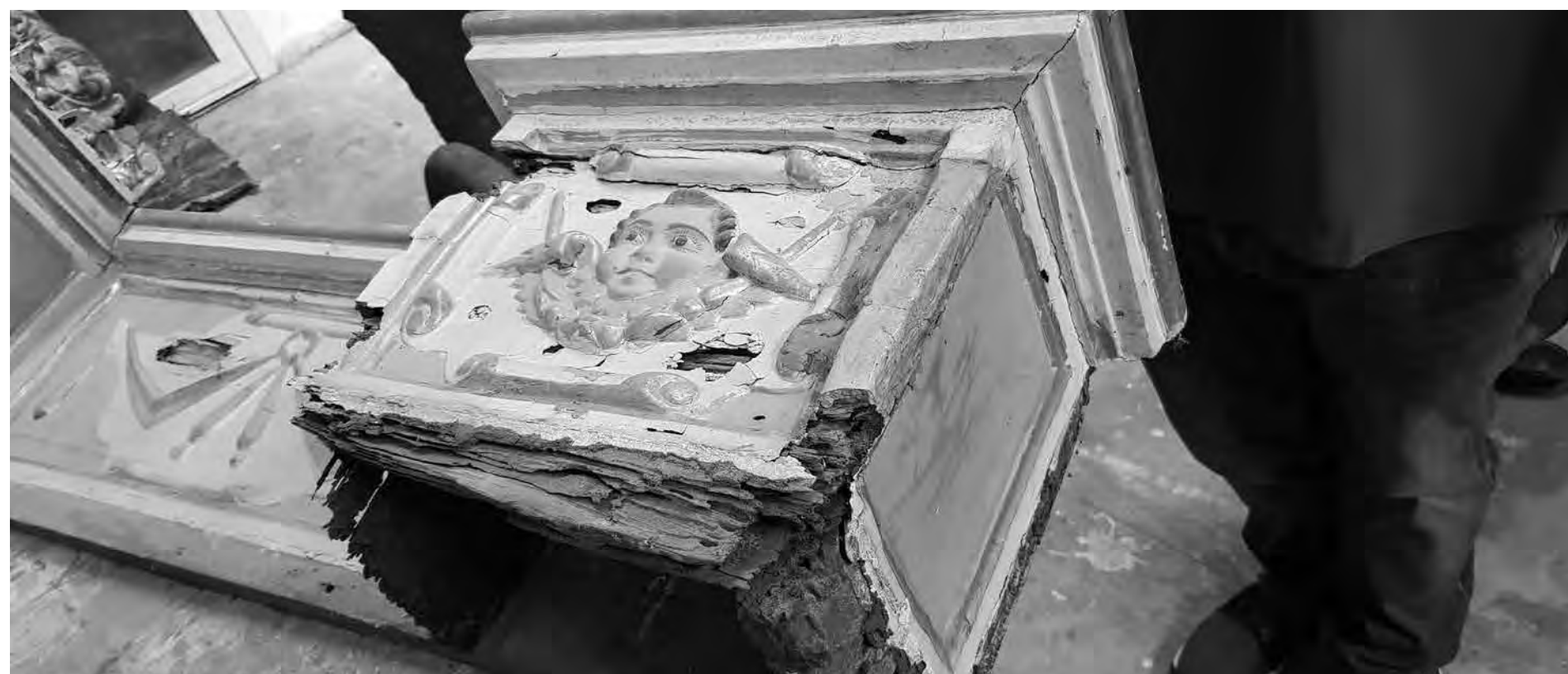
Antes e depois da obra na Igreja da Misericórdia da Soalheira.
