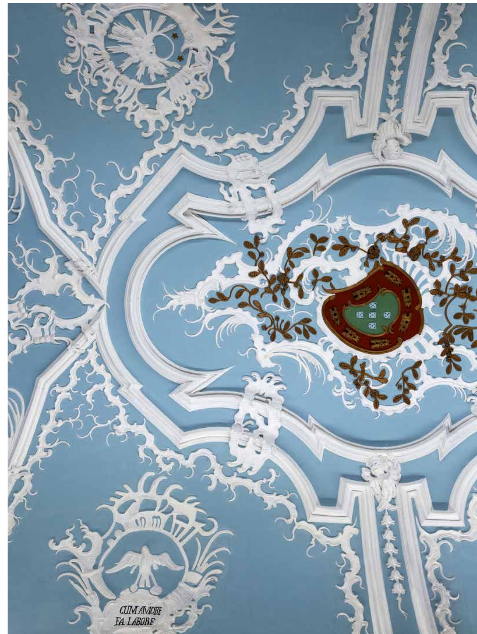
O tecto da Capela Mor ficou protegido depois do conserto do telhado.
