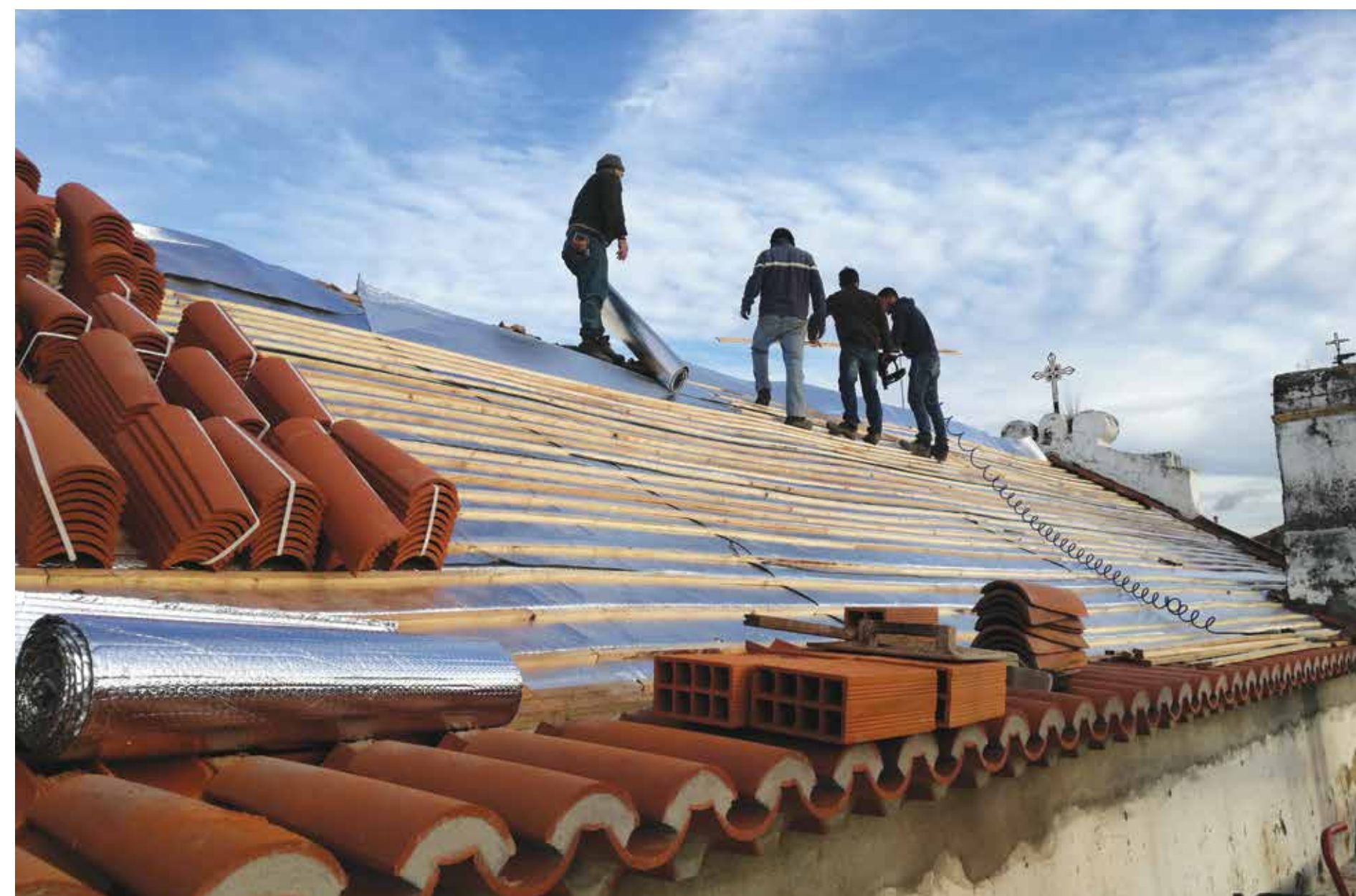
Como de costume, a recuperação da Igreja da SCM de Constância começou pelo telhado.
