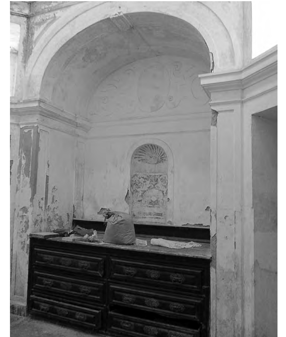
Antes e depois – Arcaz do convento da SCM de Aldeia Galega da Merceana que foi adaptado para ponto de encontro de todas as valências da Misericórdia.
