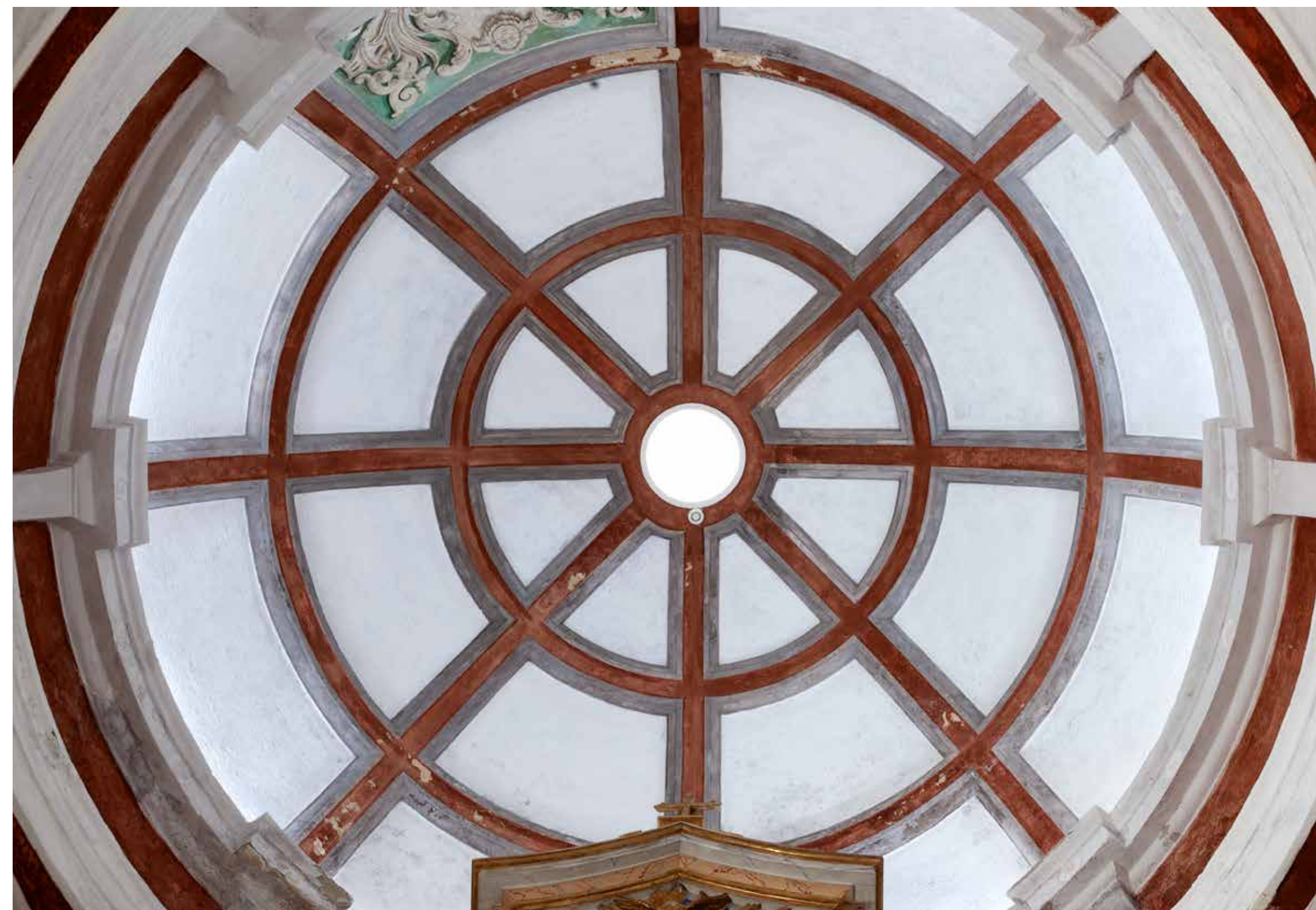
Foi descoberta a pintura primitiva da cúpula da Capela Mor. Optou-se por deixar um gomo com a pintura decorativa do século XIX.
