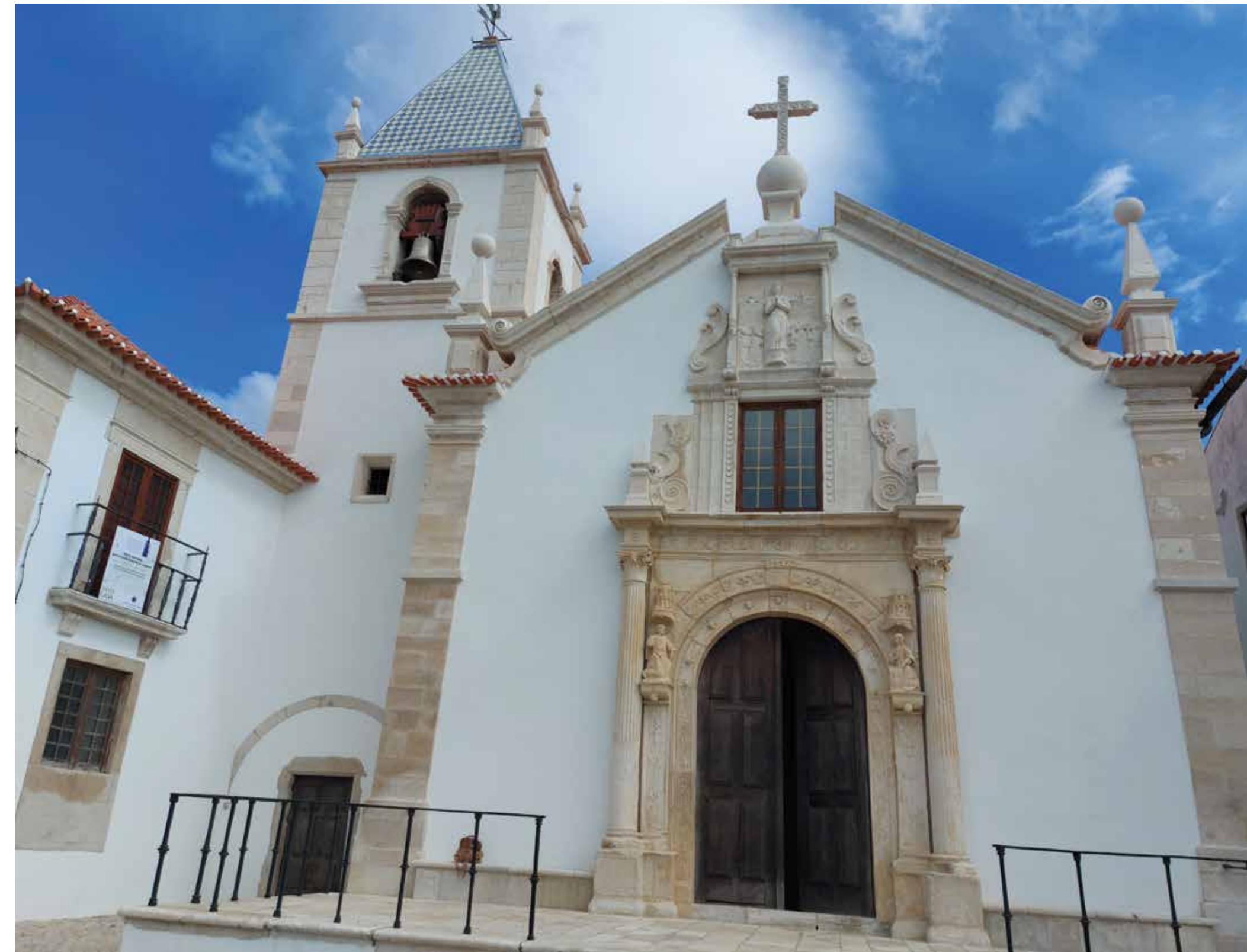
Fachada da Igreja depois da recuperação do pórtico.
