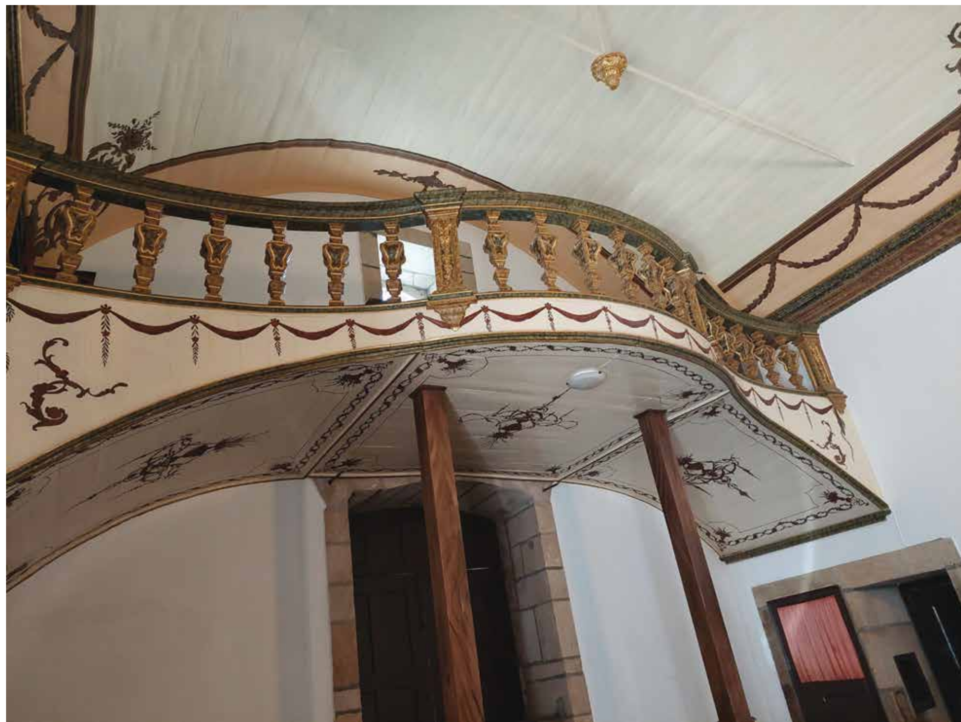
Pormenor do resultado da obra no coro alto.
