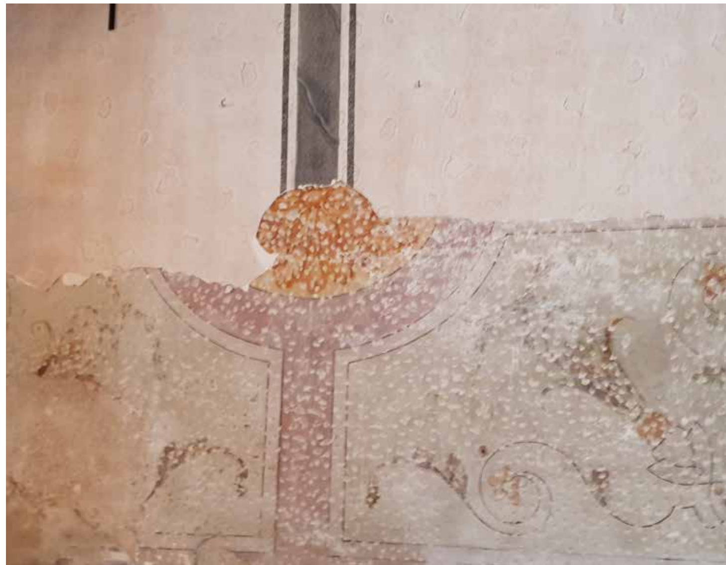
Foram abertas 'janelas' de prospecção para procurar eventuais pinturas anteriores.
