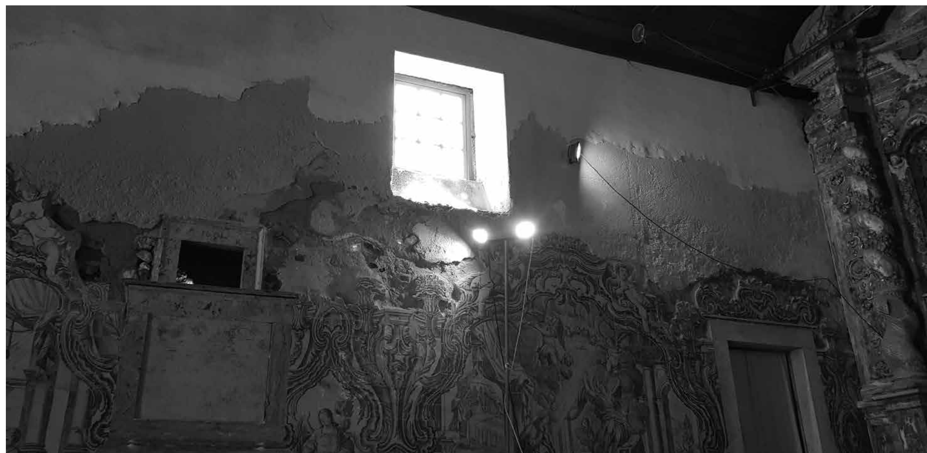
As infiltrações geravam patologias que punham em risco os painéis de azulejos.
