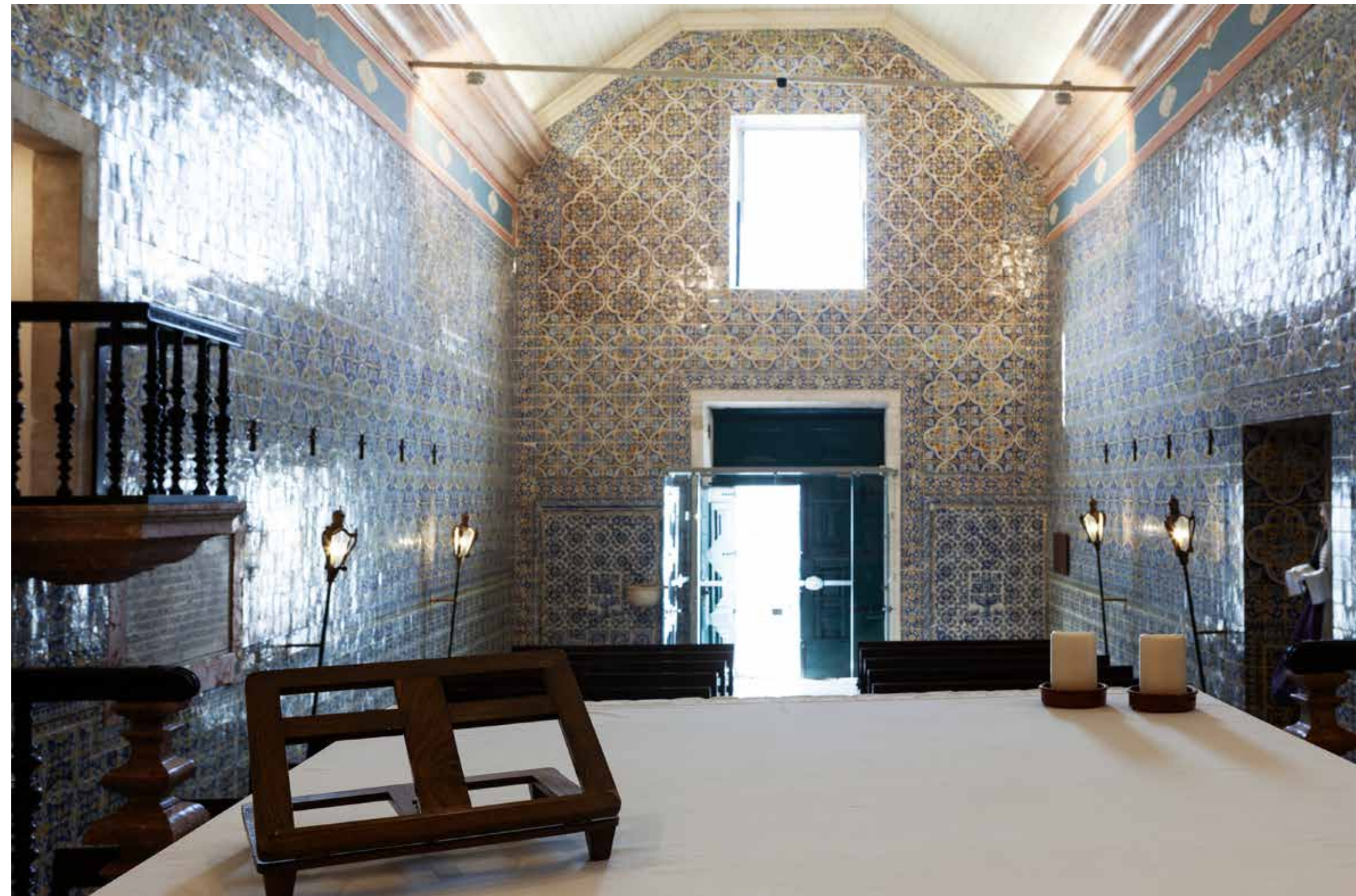
Aspecto da parte de trás da Igreja depois da obra.
