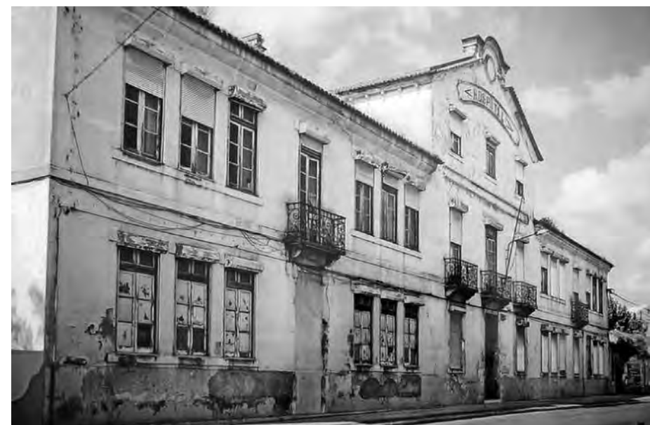
Antes e depois da obra na SCM de Almeirim.
