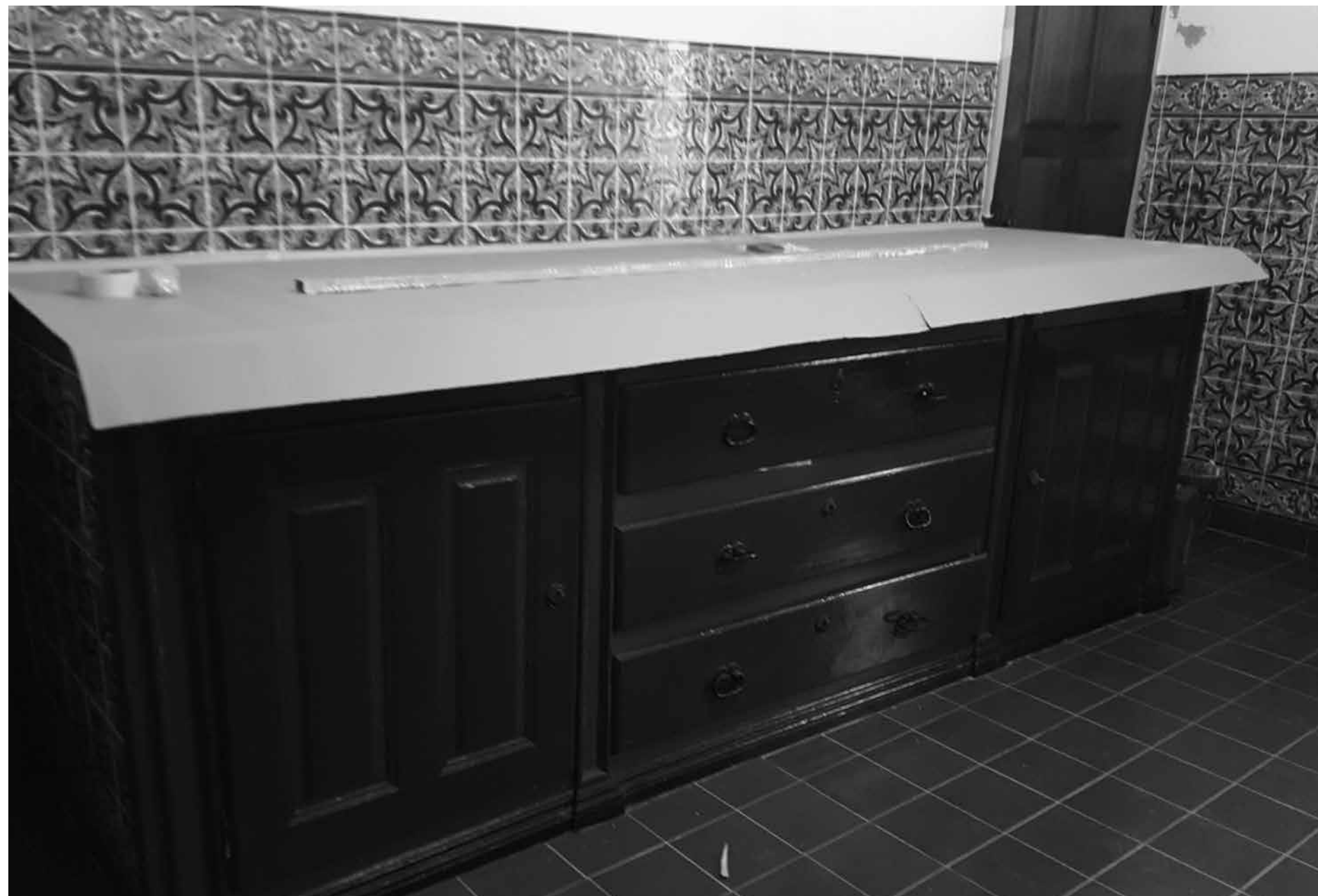
Na Sacristia foram retirados elementos espúrios como os azulejos do final do século XX e a tinta do arcaz.
