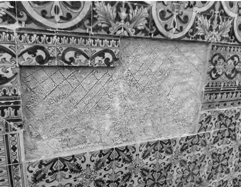
Infiltrações por múltiplas causas provocaram estragos sérios na fixação dos azulejos e nas pinturas decorativas.
