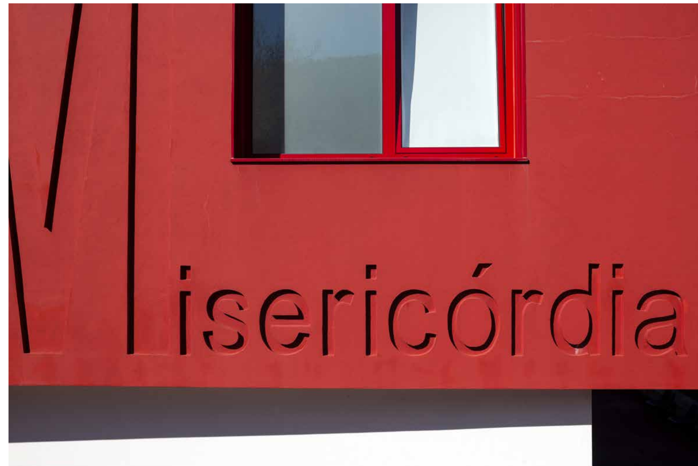
Detalhe da nova fachada do lar da SCM da Lousã.
