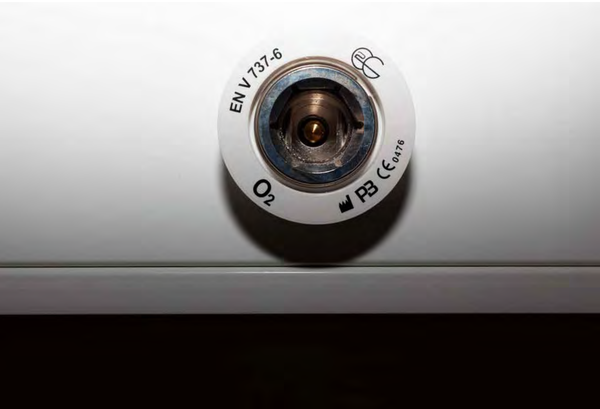
O novo lar de Alcácer do Sal ficou preparado para UCC. Pormenor de ponto de oxigénio.
