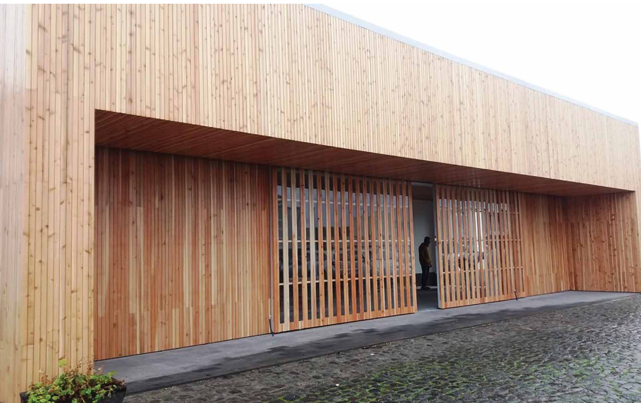
Fachada do novo Centro de Dia com ATL na SCM da Ribeira Grande.
