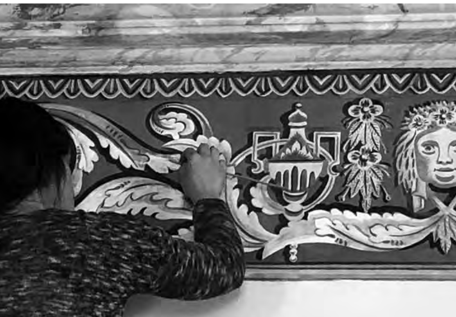
Sala do Despacho da SCM de Abrantes durante e depois do restauro.
