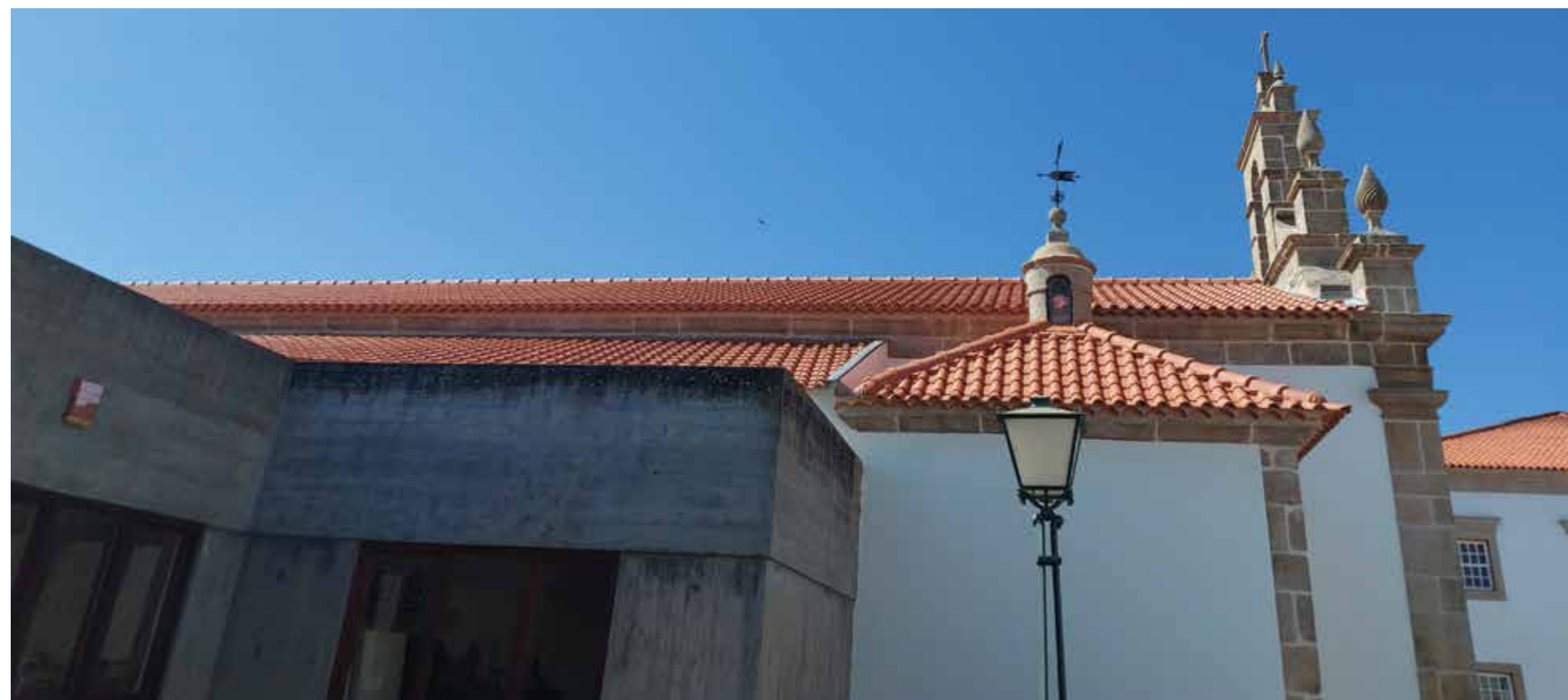
O Fundo apoiou a obra estrutural da Igreja com nova cobertura e arranjos das paredes exteriores.
