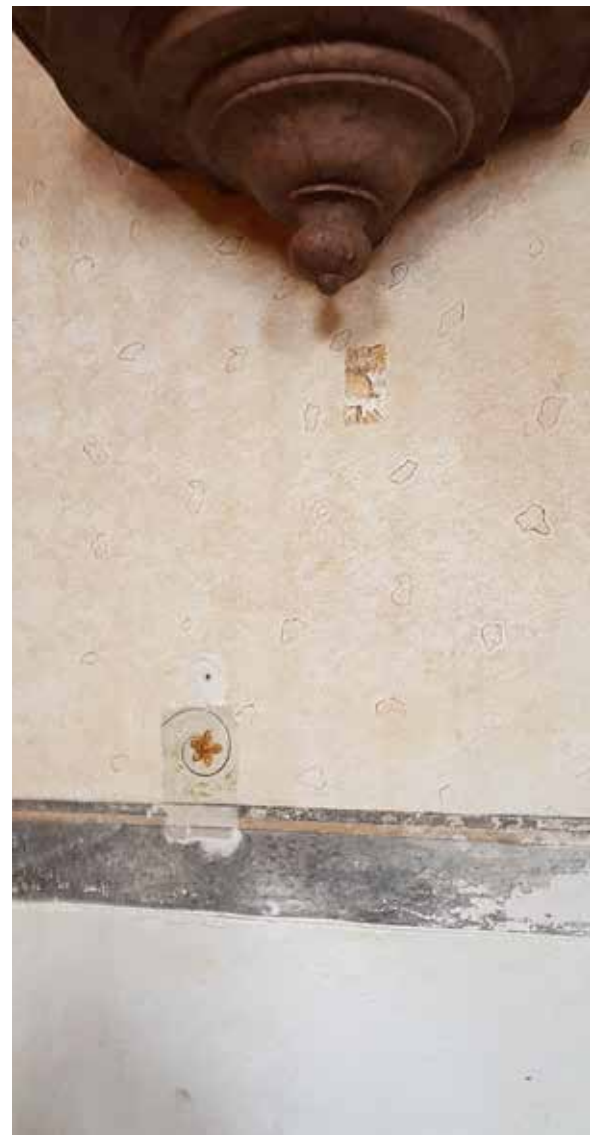
Foram abertas 'janelas' de prospecção para procurar eventuais pinturas anteriores.
